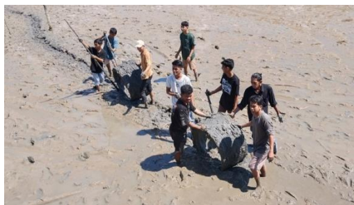
Gambar 2. Proses Penurunan Cicin untuk Septik Tank
