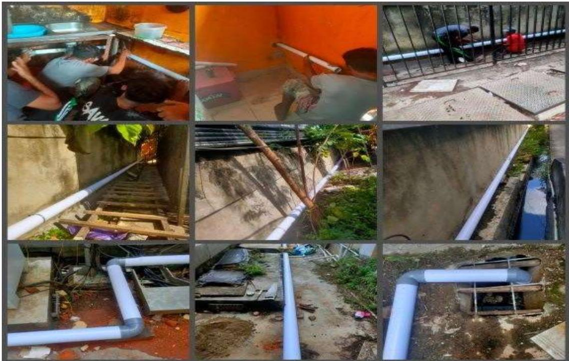
Gambar 1. Proses Pemasangan Pipa Limbah Kantin UNIVERSITAS
