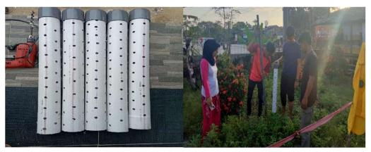
**Gambar 4** : (A)Bentuk Biopori yang sudah jadi dan (B)Proses Penggalian Tanah untuk Pemasangan Biopori
